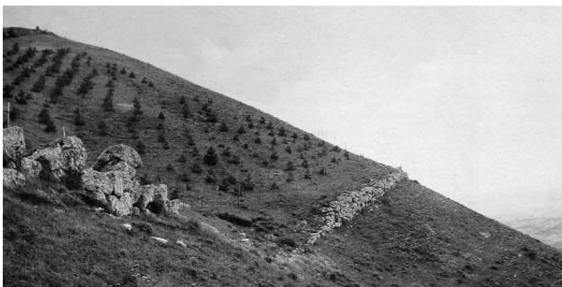
Fig. 15 - Il lato Ovest delle mura in opera poligonale di Duronia (n. 3)
