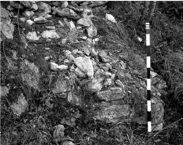
Ruderi dell'impianto per la captazione dell'acqua sorgiva di località Disciano.
